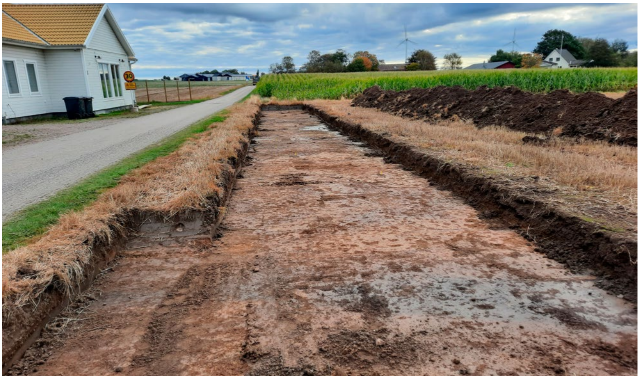
Figur 58. Schaktet i L2022:9108 västra del som grävdes i samband med schaktningsövervakningen. Foto Jonas Carlsson, mot öst. Fotonummer 2025-058- (82)
